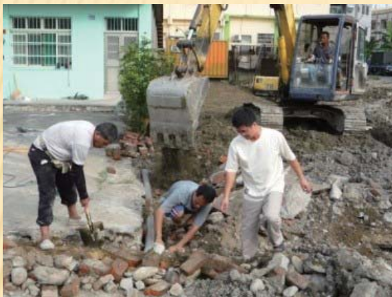
●沉沙排水溝工程
