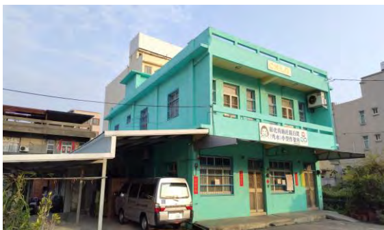
肯納秀水作業所(舊址)
